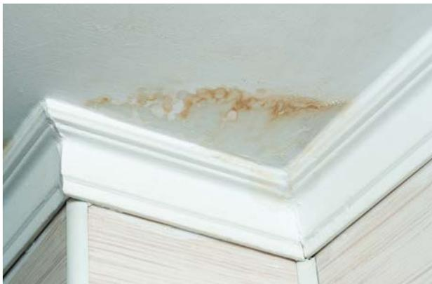
intense e localizzate, inoltre l'umidità da infiltrazione contribuisce ad aumentare la UR dell'aria esponendo l'ambiente alla umidità di condensa. La risoluzione del problema è evidentemente l'eliminazione della infiltrazione, ma non sempre è facile individuare la causa e spesso la realizzazione dei lavori necessari può essere onerosa, esponendo l'ambiente alla umidità per tempi prolungati, con tutte le conseguenze del caso sulle strutture e sulla salubrità.
